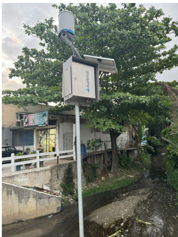
Imagem 11: Estação Hidrológica na Avenida Irene Lopes Sodré, Engenho do Mato.
